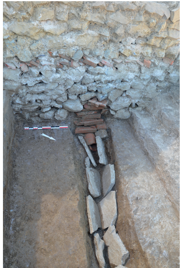
Fig. 7. La canalisation F16 débouchant de la cave J. À l'arrière-plan, la face externe du mur oriental de la cave (© Université libre de Bruxelles).
